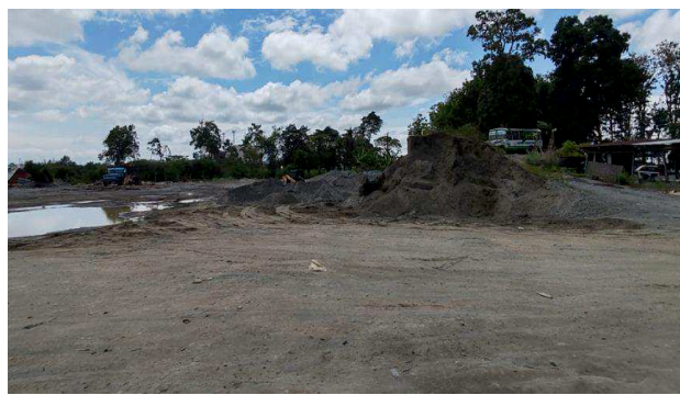
Imagen No. 7 Acopio de material de cantera sobre el área inspeccionada.
