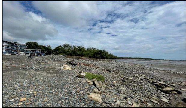
Imagen No. 3 Posible afectación en zonas con características técnicas descritas en el artículo 167 del Decreto Ley 2324 de 1984.
