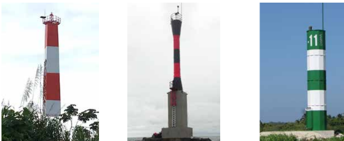
Figura 5. De izquierda a derecha se observan: faro Guapi, baliza El Viudo y faro de orilla de Barranquilla.
