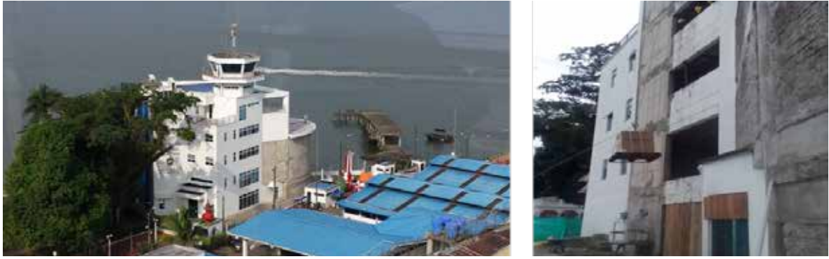
Figura 14. Reforzamiento estructural a la Capitanía de Puerto de Buenaventura.
