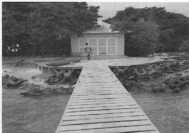
Imagen No 3. Vista general del muelle 3.
