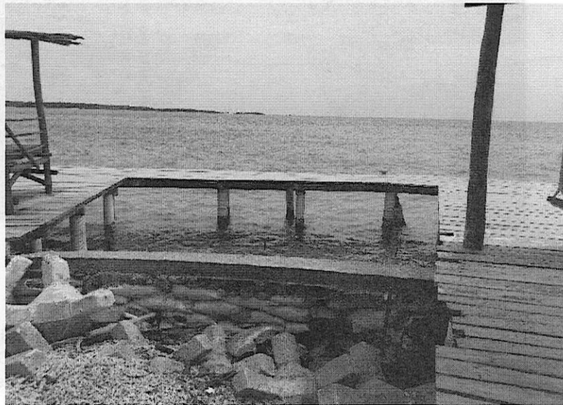
Imagen No 1. Vista general del área donde se localiza el muelle 1.
