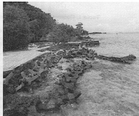
Imagen No 8. Vista general de la protección costera.
