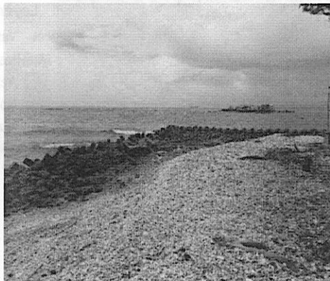
Imagen No 5. Vista general de la protección costera.
