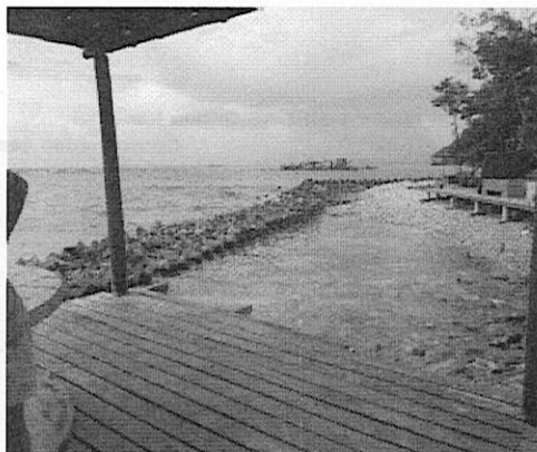
Imagen No 7. Vista general de la protección costera.
